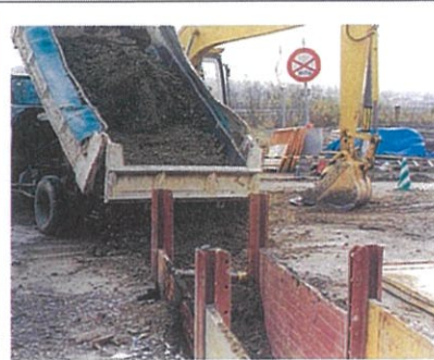
管工事の埋め戻し
