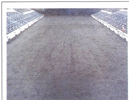
河川底 補修例
