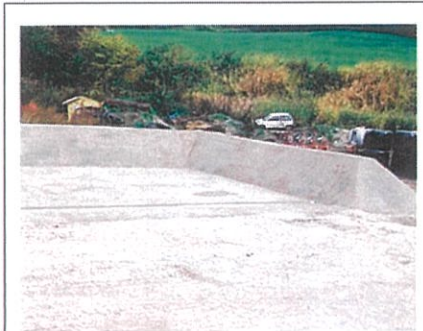
堆肥盤の造成
