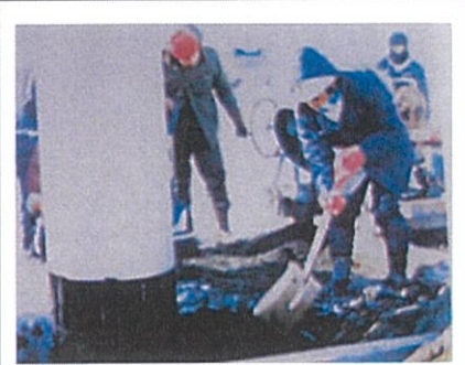
電柱根固工事
