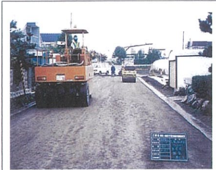
上層・下層路盤の造成
